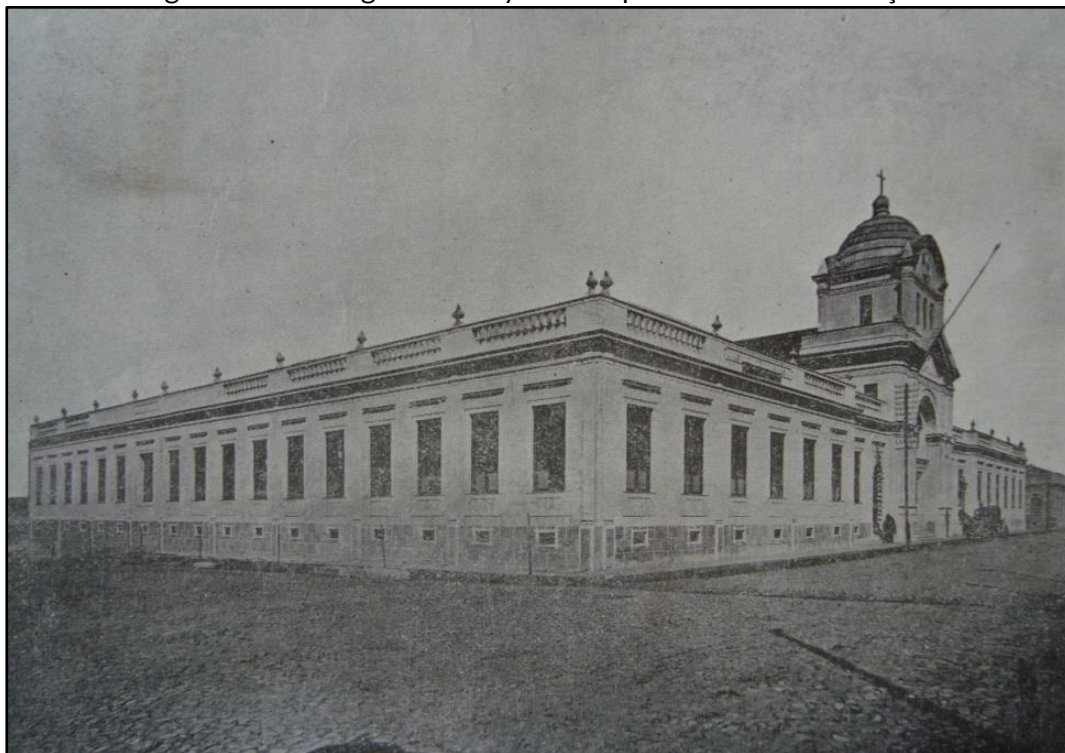
Figura 1 – “Vista geral do Asylo de Órphãs N. S. da Conceição”
