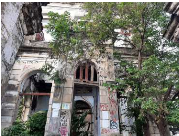
Figura 8. Recorte da fachada do Casarão da Várzea
