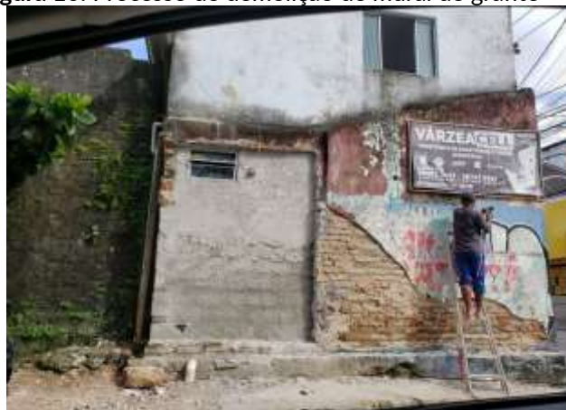
Figura 10. Processo de demolição de mural de grafite
