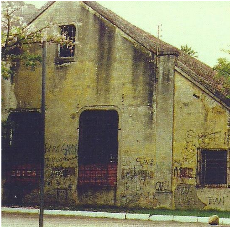
Figura 14: Vista dos fundos do prédio após sua interdição. Ano: 1998.
