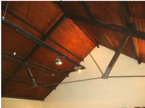
Figura 11: Tesoura “Polonceau” utilizada no prédio do atual museu da UFRGS. Ano: 2012.
