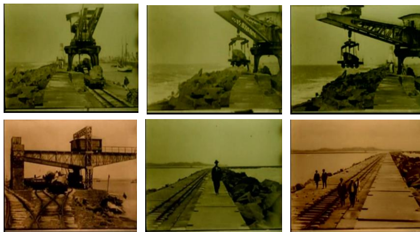
Figura 6. Construção do Quebra-mar e Molhe
